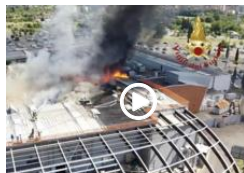
Ponte a Greve, l'intervento dei vigili del fuoco sul tetto della...
