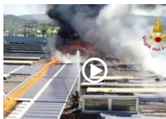
Scandicci, il tetto in fiamme della Coop di Ponte a Greve
