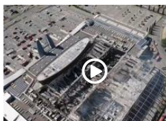
Coop Ponte a Greve, il tetto crollato: quello che resta dopo l'incendio
